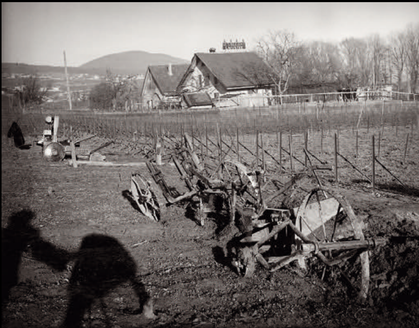
Défonçage à la charrue Sack et treuil Gloppe
