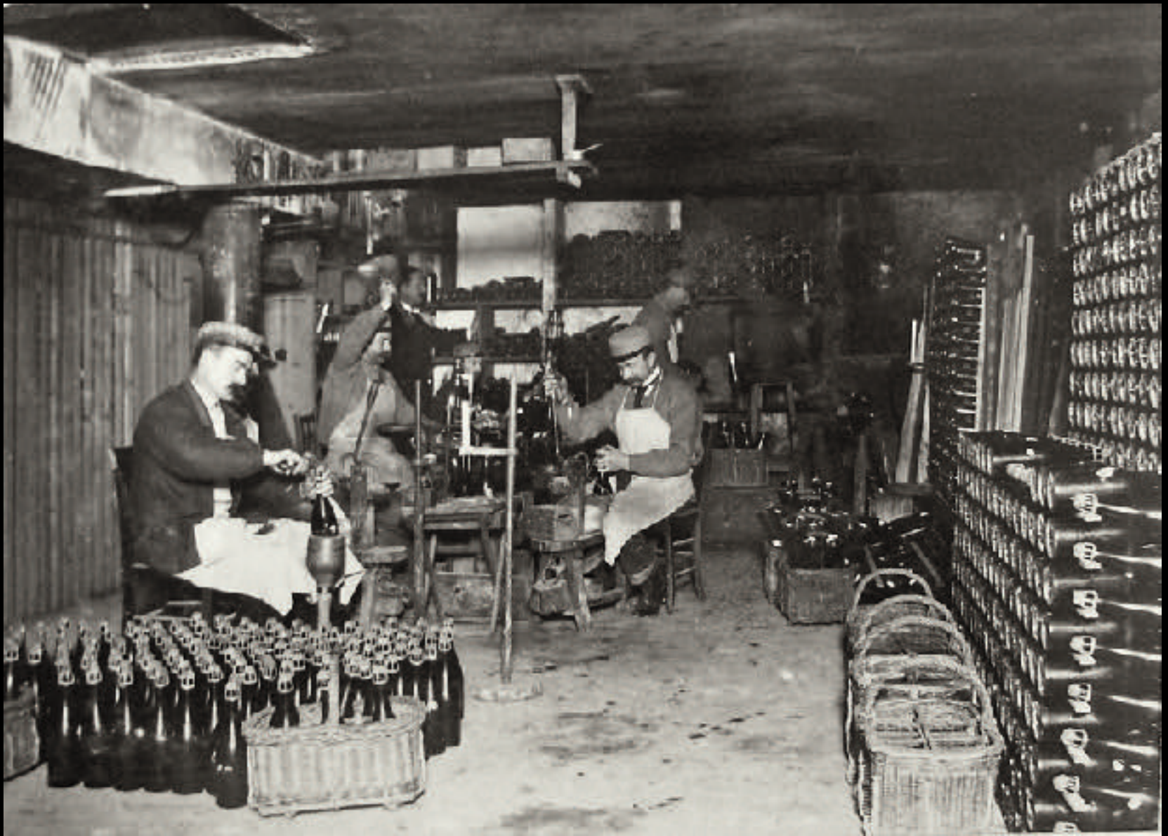
Dégorgement, dosage, bouchage, museletage et poignettage
