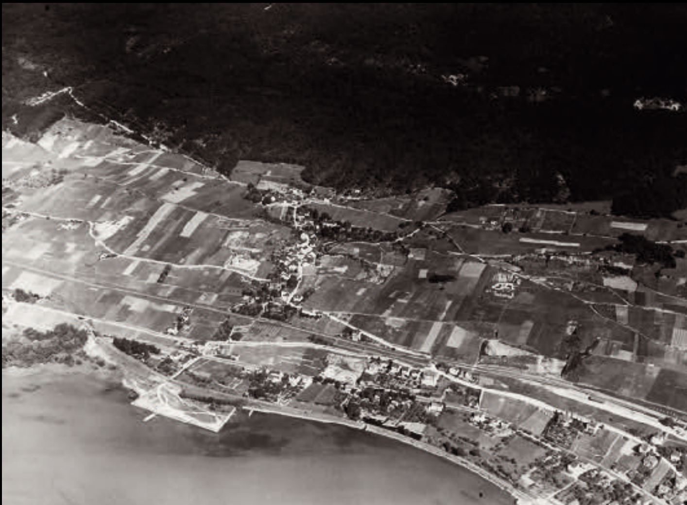
Vue aérienne vers 1920 du village de Hauterive
